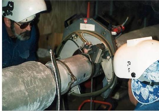
*Круговая сварка TIG/GTAW с горячей проволокой твердой двойной высоколегированной или нержавеющей магистральной трубы*
