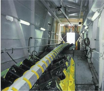
*Монтаж S-Lay в трубоукладчике*
