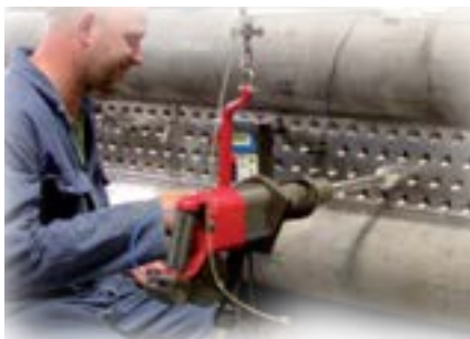
Сварка по обратной поверхности трубной доски двустенного коллектора
