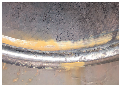
Рис. 19- Профиль сварного шва в потолочном положении, труба \varnothing 168 мм (сварка без формирующего газа)
