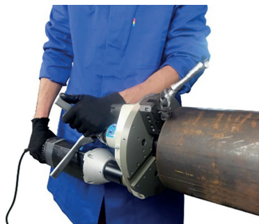
Рис. 9 - Подготовка кромки под сварку установкой типа US40
