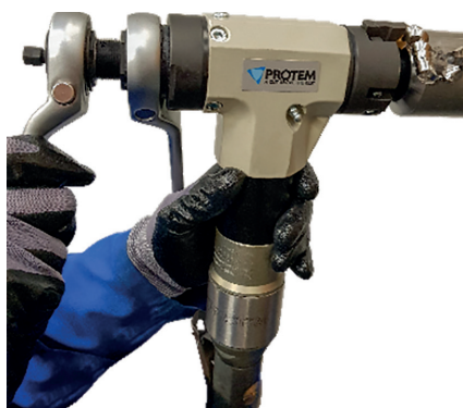
Рис. 10 - Подготовка кромки под сварку установкой типа US25CH
