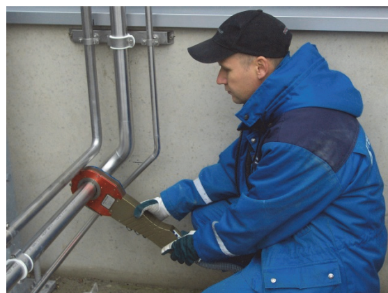
б) Сварка трубопровода
