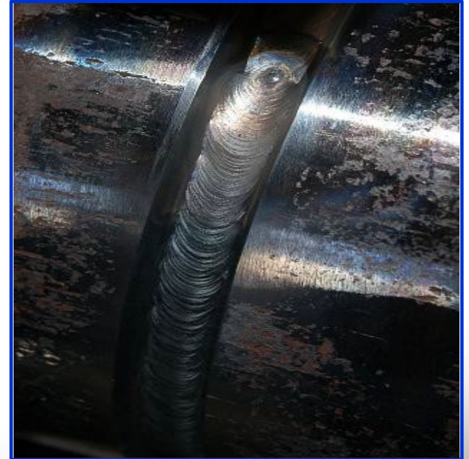
Внешний вид корневого (первого) слоя шва
